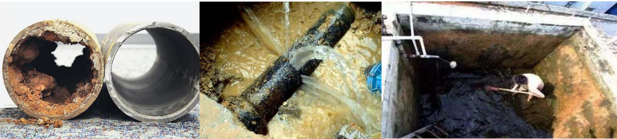
输水管道老化、破裂，存在二次污染；
